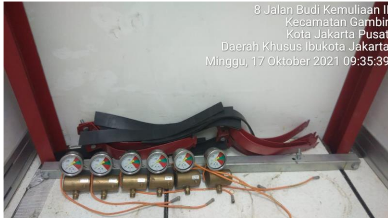
Gambar 3.2 Cylinder Strap yang sudah dilepas
